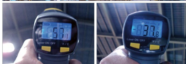
Intradosso tetto capannone (prima-dopo): la temperatura è stata ridotta di 19,3°C. Impiego: condizioni di lavoro migliorate, risparmio energetico, riduzione dei costi di manutenzione del tetto.
